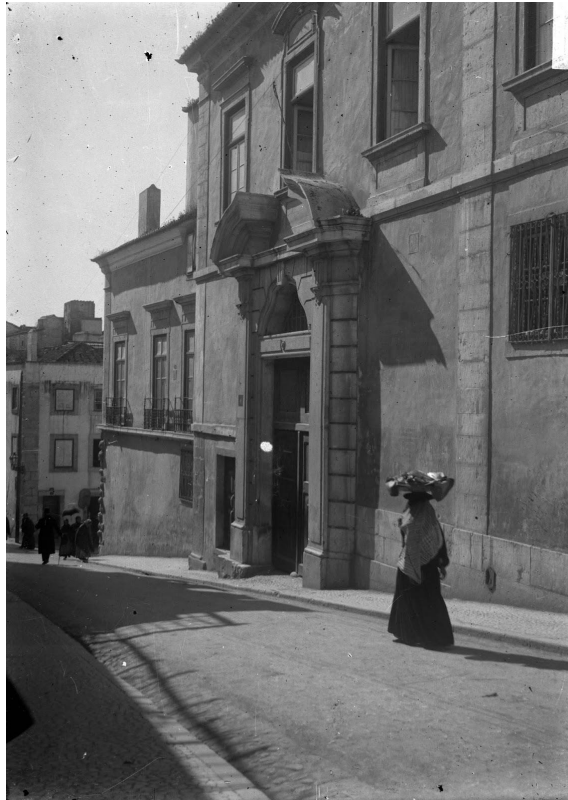
7. Palazzo, facciata levante (1893), (da http://lisboahojeontem.blogspot.it/2013/03/arco-de-santo-andre-palacio-condes-da.html )
