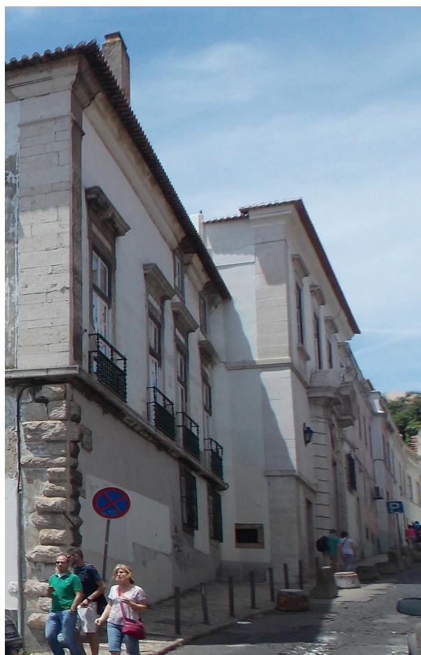
10. Palazzo, facciata levante (maggio 2014), (da www.google.it/maps ).
